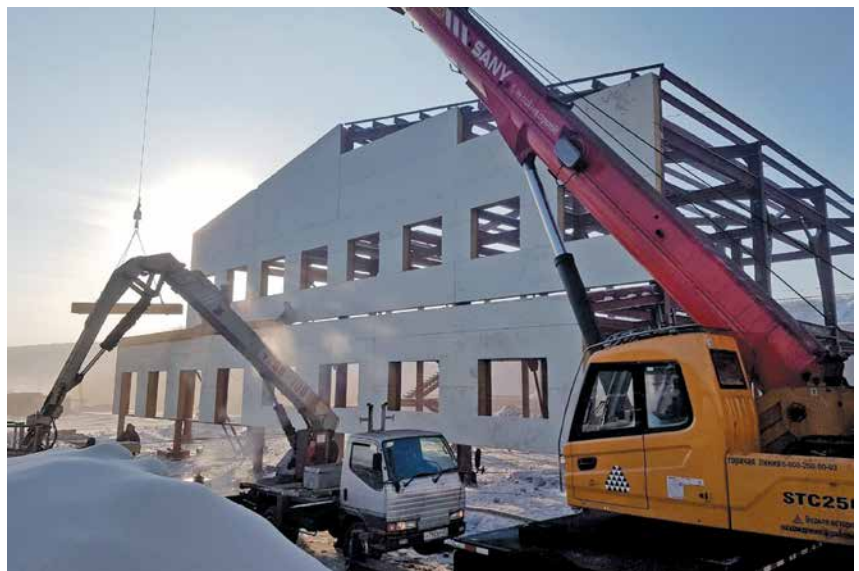
Строительство пожарного депо
